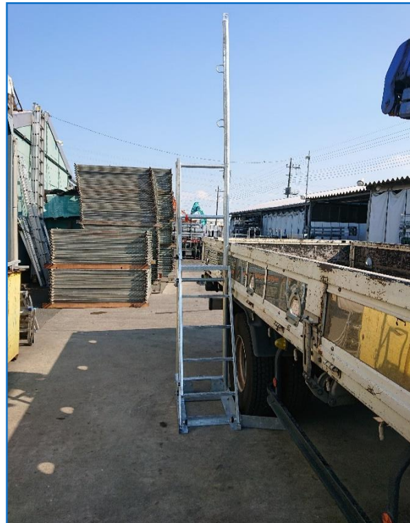
⑮設置完了
