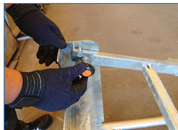
⑥支柱中間部ピン抜き
